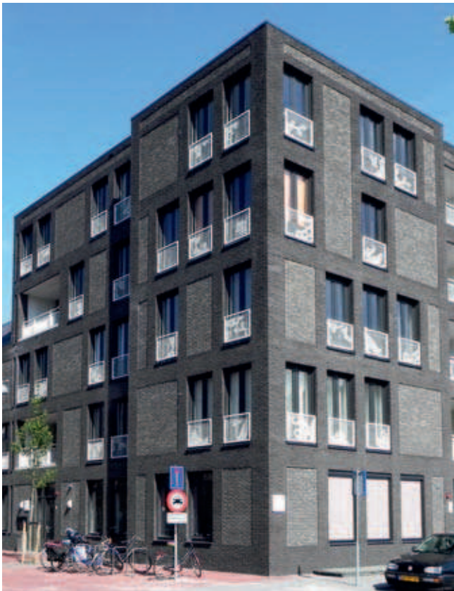
Totaal van het gebouw
